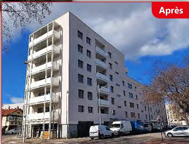
L'extension-surélévation a notamment permis l'intégration d'un ascenseur, dans une résidence qui n'était pourvue que d'un seul équipement avant transformation. Les rez-de-chaussée sont également restructurés : les garages laissent place à des halls agrandis, de nouveaux locaux poussettes, de nouveaux locaux vélos, des locaux OM/tri agrandis, un nouveau local gardien et de nouvelles caves.
